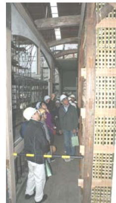
今しか見れない壁の下地を見ることが出来ました
